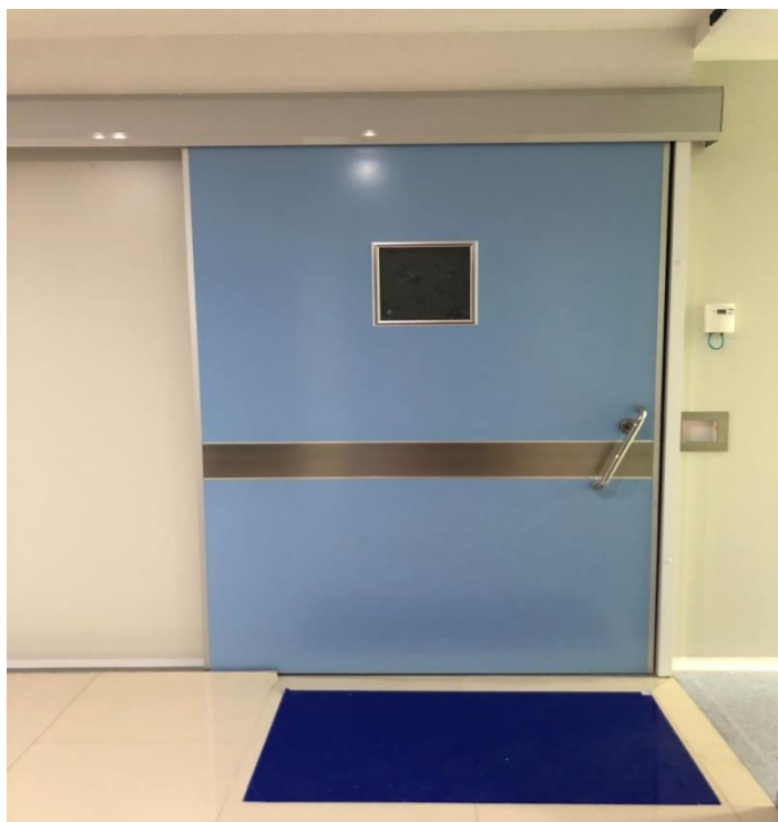
รูปภาพที่ 3 ก่อนนักวิทยาศาสตร์จะเข้าไปยังห้องปฏิบัติการจะต้องเปลี่ยนรองเท้าและย่ำลงบน sticker mat ซึ่งวางติดไว้บริเวณทางเข้าห้องปฏิบัติการเพื่อช่วยลดฝุ่นที่ติดมากับรองเท้า
