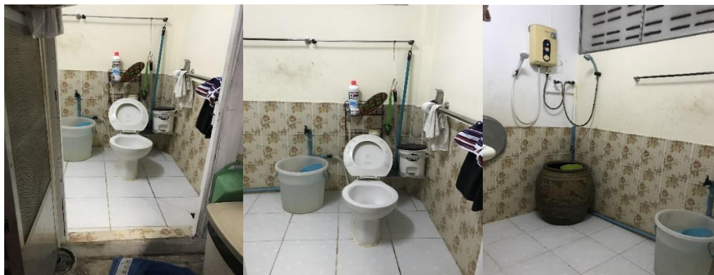
ภาพที่ 57 แสดงห้องน้ำผู้สูงอายุในที่อยู่อาศัย บันไดขึ้นชั้น 2 ผู้สูงอายุใช้งานชั้น 2 ในกรณีที่ตากผ้าเท่านั้น บันไดมีราวจับข้างเดียว
