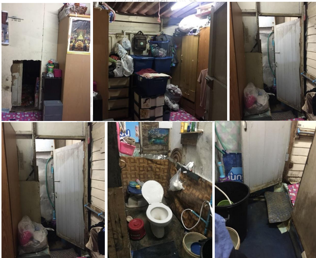
ภาพที่ 71 แสดงห้องน้ำผู้สูงอายุในที่อยู่อาศัย
