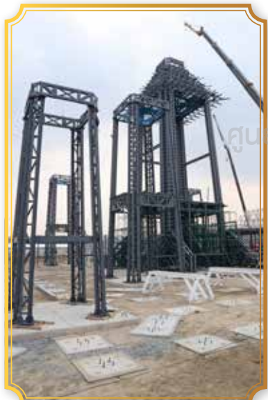
การถ่ายแรงจากโครงเหล็กบุษบกลงสู่ฐานราก ภาพโดย วุฒพิชัย อัครเลิศวิสุทธิ
