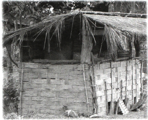
ขัดแตะ หรือ เรียกอีกอย่างหนึ่งผาแตะ เป็นการใช้เรียกชื่อผาเรือน เครื่องผูกที่ใช้ไผ่ซีกสอดขัดกันกับลูกตั้ง
