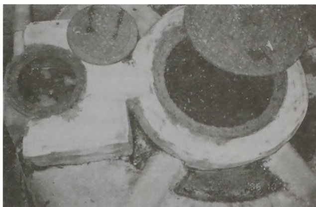
ช่องกลมด้านซ้ายเป็นถังตกตะกอน ช่องขวาเป็นถังกรองและย่อยสลาย สารอินทรีย์ เป็นก๊าซ CO 2 และ CH 4 (มองเห็นฟองก๊าซที่ผิวน้ำ)
