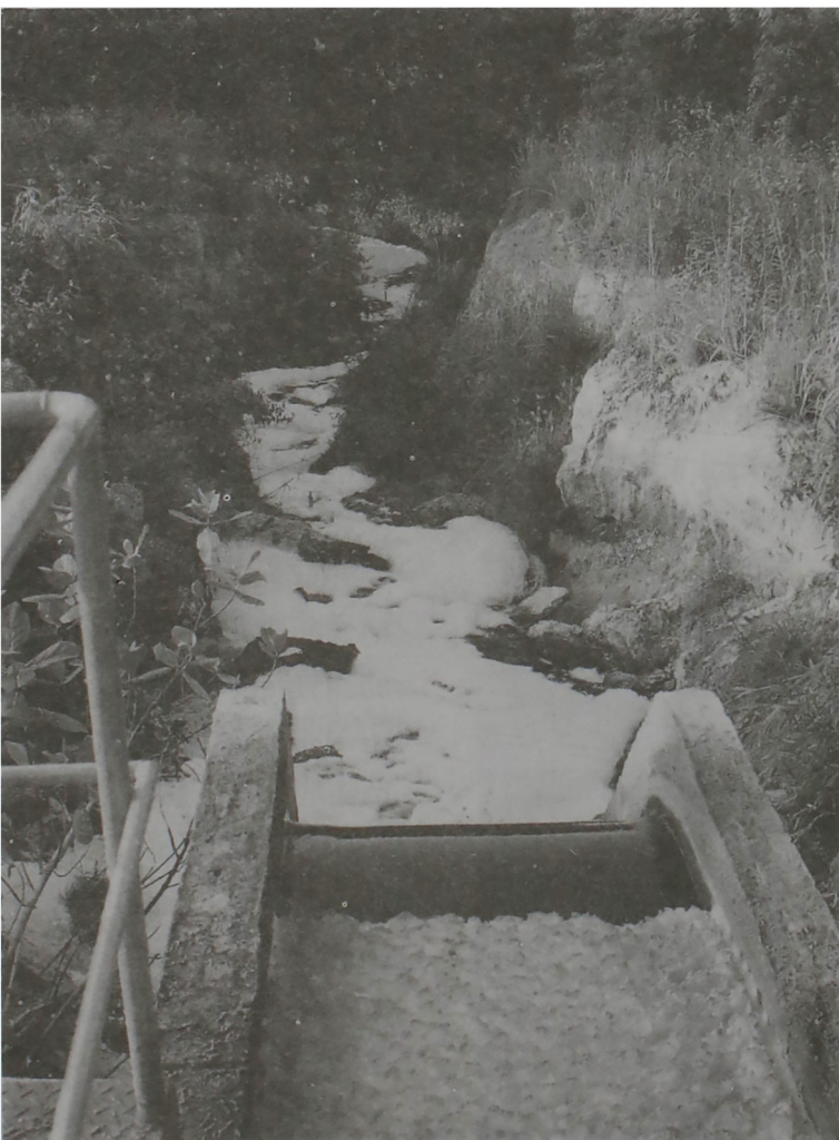
น้ำเสียที่ผ่านการบำบัดแล้วก่อนปล่อยลงสู่ห้วยโจด
