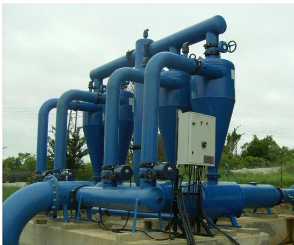
รูปที่ 7 ไฮโดรไซโคลนในงานบำบัดน้ำเสีย
