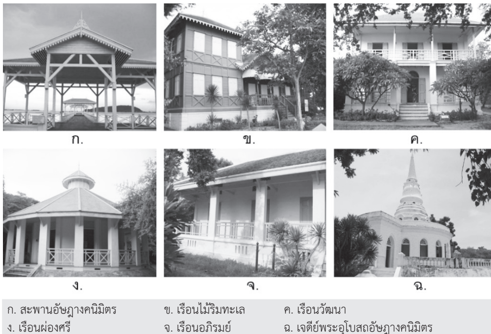
รูปภาพที่ 2 สิ่งปลูกสร้างที่สำคัญภายในพระจุฬาราชราชนัน
