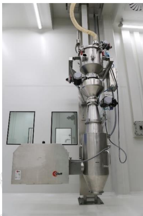
รูปที่ 8 เครื่องบดลดขนาดแกรนูลแห้ง สามารถเคลื่อนที่ขึ้นลงได้ เพื่อให้เหมาะสมกับความสูงของถัง Intermediate bulk container
