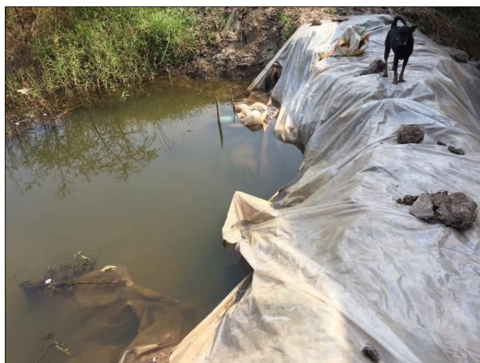
ภาพคันการตักดินกันคลองระบาย
