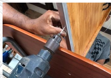
ภาพที่ 251 เจาะรูเหล็ก ที่มา : ผู้วิจัย
