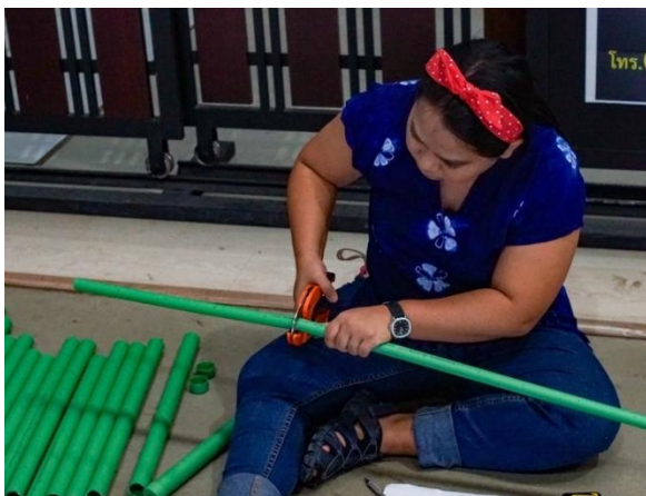
ภาพที่ 31 ตัดท่อ PPR
