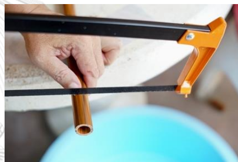
ภาพที่ 84 ตัดท่อลมรายขนาดกลาง ที่มา : ผู้วิจัย
