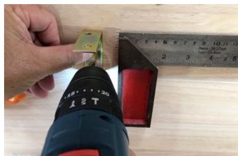
ภาพที่ 188 ยึดเหล็กฉาก ที่มา : ผู้วิจัย
