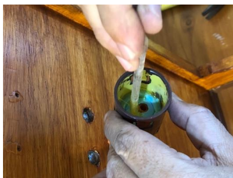
ภาพที่ 325 ทากาวยางด้านในข้อต่อ
