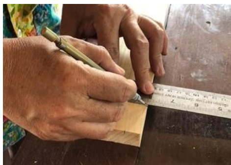
ภาพที่ 231 ร่างตำแหน่งบากไม้ 2 ที่มา : ผู้วิจัย
