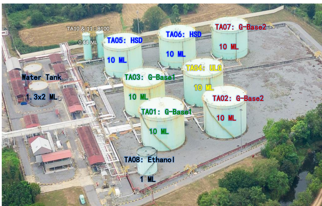
รูปที่ 1.5 แผนผังถังเก็บน้ำมันและสารอื่น ๆ
