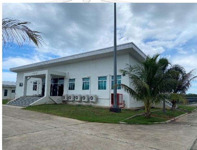
รูปที่ 4 ศูนย์ควบคุมโรงไฟฟ้าพลังงานแสงอาทิตย์
