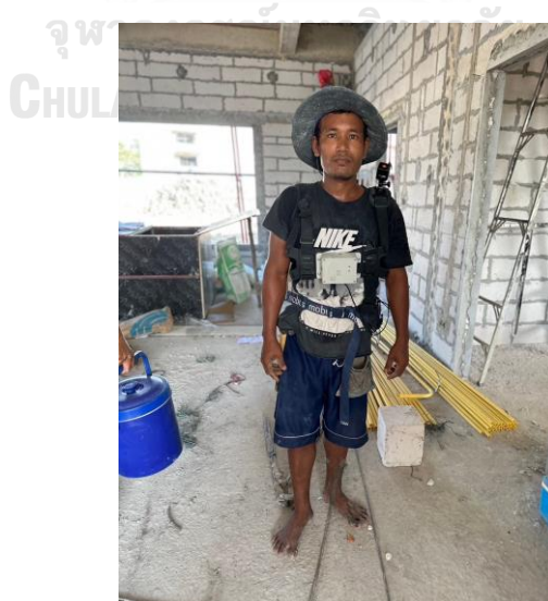
รูปที่ 5.39 รูปภาพแสดงแรงงานที่ติดตั้งเครื่องมือวัดปริมาณมลพิษทางอากาศและเสียงส่วนบุคคล (กิจกรรมงานประกอบแบบหล่อคอนกรีต คนที่ 1)
