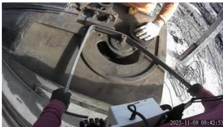
รูปที่ 5.3 รูปภาพแสดงกิจกรรมตัดและตัดเหล็ก (โครงการกรณีศึกษาที่ 1)
