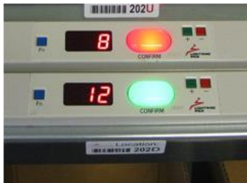
ก) อุปกรณ์ไฟฟ้า
