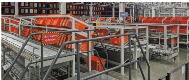
รูปที่ 1-8 ตัวอย่าง Island ภายในสถานีงาน Secondary Assort
