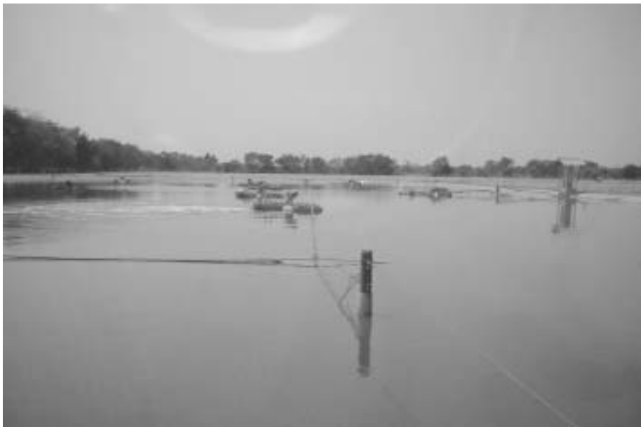
บ่อบำบัดน้ำเสียขนาดใหญ่ภายในบ่อฝังกลบของเทศบาลเมืองพิจิตร (ภาพโดย ดร.ทรงกฤษณ์ ประภักดิ์)
