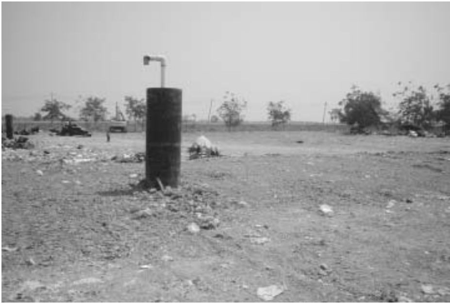
การปิดหน้าดินทุกวันและระบบระบายก๊าซจากภายในบ่อขยะของเทศบาลเมืองพิจิตร (ภาพโดย ดร.ทรงกฤษณ์ ประภักดิ์)
