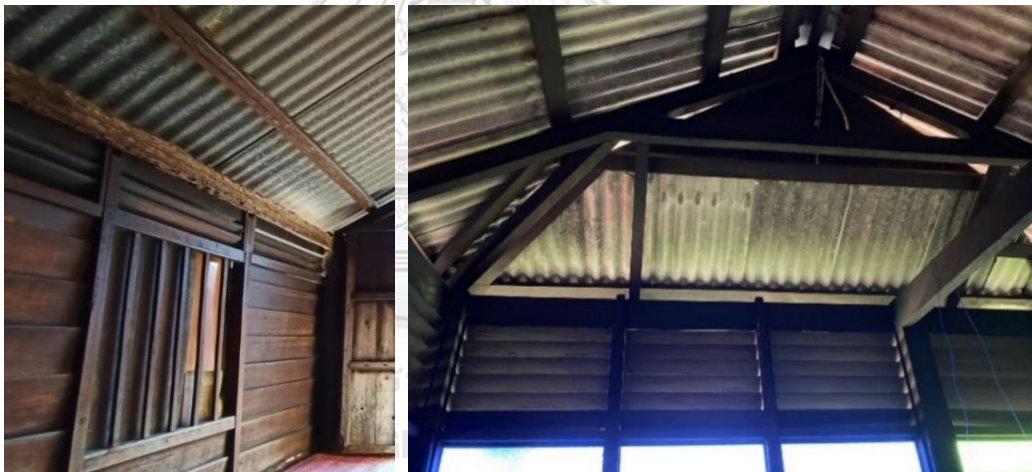
ภาพที่ 20 ภาพลักษณะของช่องหน้าต่างพบในรูปแบบที่ 1 กลุ่มเรือนหลังคาทรงจั่วสูงหรือปีกนก (กลุ่มเรือนที่มีช่วงอายุมากกว่า 100 ปี) ที่มา : ผู้วิจัย, 2565
