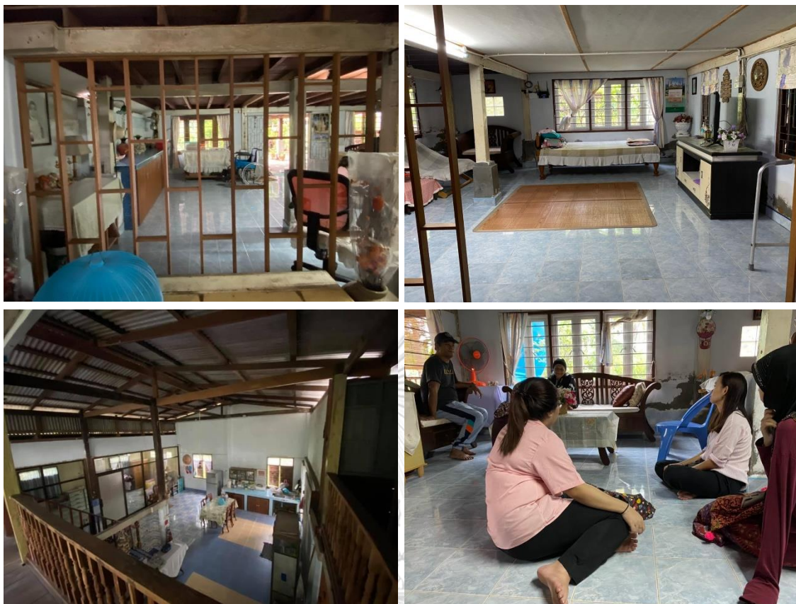
ภาพที่ 121 การต่อเติมชั้นใต้ถุนเป็นชั้นปูน
