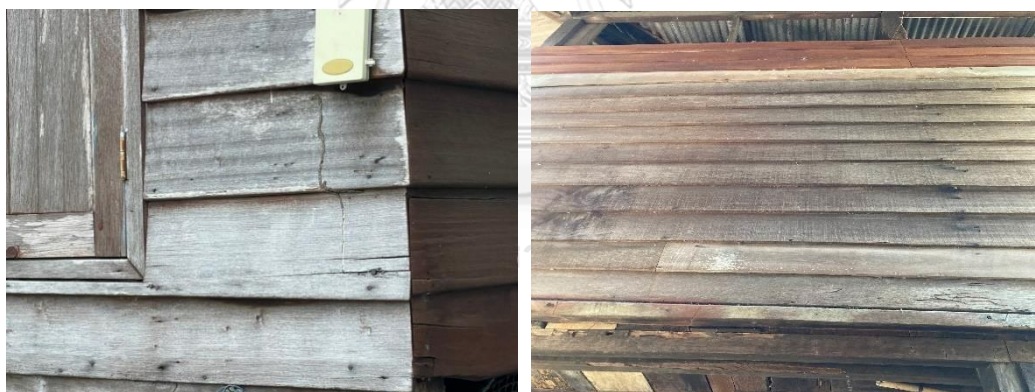
ภาพที่ 28 ผนังที่พบในกลุ่มเรือนหลังคาทรงแปริ่ง (กลุ่มเรือนที่มีช่วงอายุที่ 80 -100 ปี ) ที่มา : ผู้วิจัย, 2565
