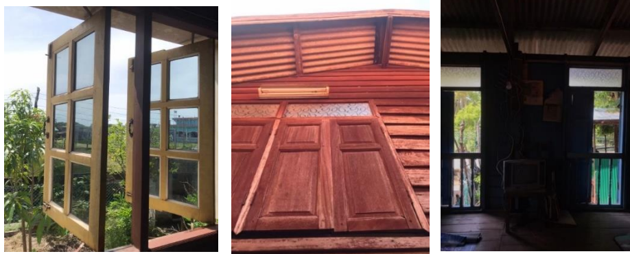
ภาพที่ 39 ลักษณะช่องเปิด ช่องแสงหรือช่องลมที่พบในกลุ่มเรือนหลังคาทรงจั่ว (กลุ่มเรือนที่มีช่วงอายุ 40 - 60 ปี) ที่มา : ผู้วิจัย, 2565
