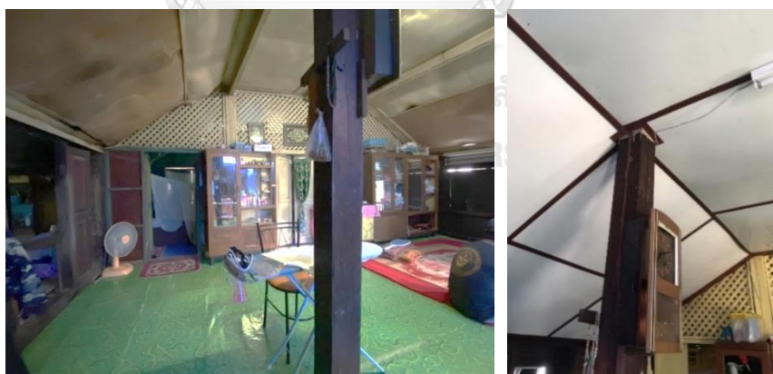
ภาพที่ 51 ภาพการเปลี่ยนแปลงและต่อเติมฝ้าเพดานภาพซ้ายเป็นภาพฝ้าเพดานเดิม - ภาพขวาเป็นภาพฝ้าเพดานใหม่
