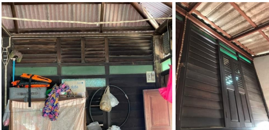
ภาพที่ 27 ลักษณะช่องเปิดของกลุ่มเรือนหลังคาทรงแปริ่ง (กลุ่มเรือนที่มีช่วงอายุที่ 80 -100 ปี ) ที่มา : ผู้วิจัย, 2565
