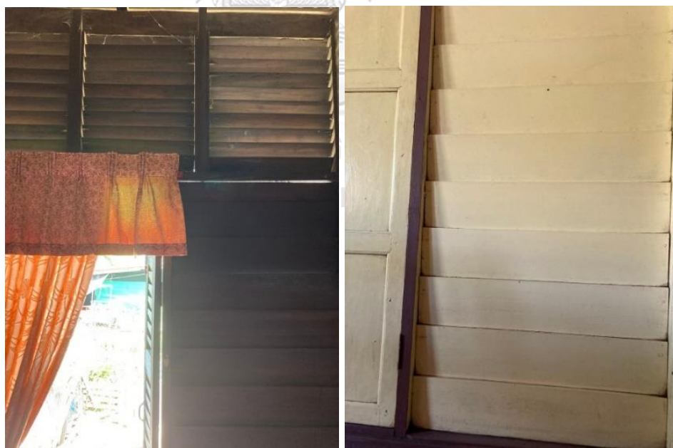
ภาพที่ 34 ลักษณะช่องเปิด ช่องแสงหรือช่องลม ที่พบในกลุ่มเรือนหลังคาทรงแปดเหลี่ยม (กลุ่มเรือนที่มีช่วงอายุ 60 - 80 ปี) ที่มา : ผู้วิจัย, 2565
