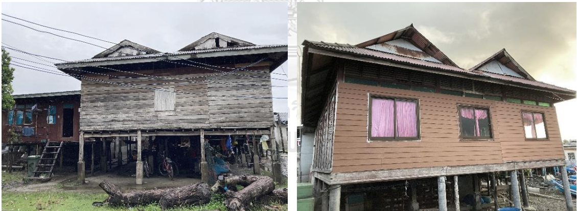
ภาพที่ 25 รูปแบบที่ 2 กลุ่มเรือนหลังคาทรงแปริ่ง (กลุ่มเรือนที่มีช่วงอายุที่ 80 - 100 ปี ) ที่มา : ผู้วิจัย, 2565
