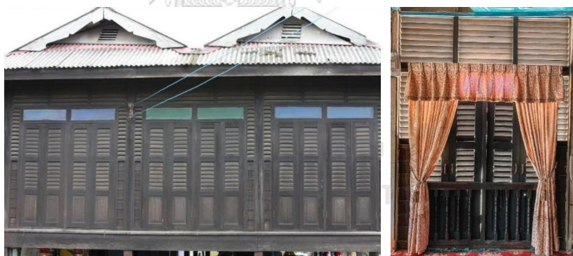
ภาพที่ 33 ลักษณะช่องเปิด ช่องแสงหรือช่องลมที่พบในกลุ่มเรือนหลังคาทรงแปดกร่วมสมัย
