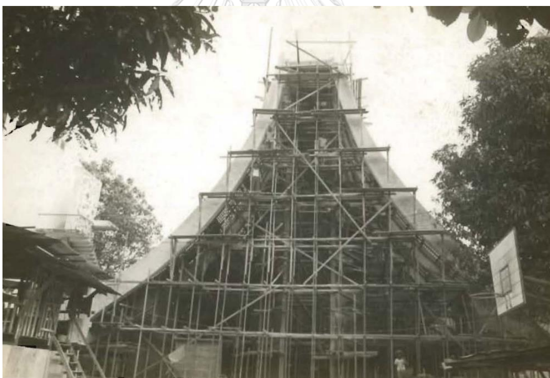
ภาพที่ 73 แสดงการก่อสร้างจันทันคอนกรีตเสริมเหล็ก (R.C. rafter) เป็นโครงสร้างหลักของอาคาร และติดตั้ง ระแนงไม้ฉลุด้วยกระเบื้องหลังคาดินเผา ขนาด 1"X1" ที่มา : บราเดอร์ พันธรักษ์ เรืองสวัสดิ์, เอส.เจ., พ่อบ้านประจำวัดบ้านเซเวียร์, 17 มีนาคม 2562.
