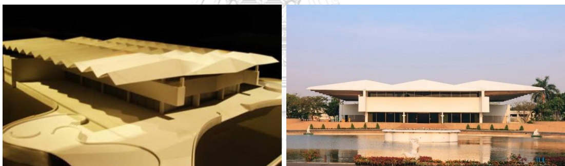
ภาพที่ 25 อาคารใหม่สวนอัมพร ใช้โครงหลังคาเป็นโครงพับจีบ (Folded Plates)
