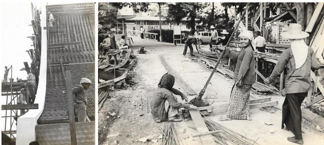
ภาพที่ 74 แสดงการติดตั้งกระเบื้องหลังคา และการตัดเหล็กเสริม สำหรับทำโครงสร้างโบสถ์บ้านเซเวียร์ โดยทีมช่างของ โกภภัทร ผู้รับเหมาหลักของโครงการ 217
